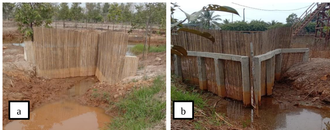
Gambar 4. Hampang bambu: (a) tampak belakang, (b) tampak depan Sumber: Dokumentasi pribadi.
