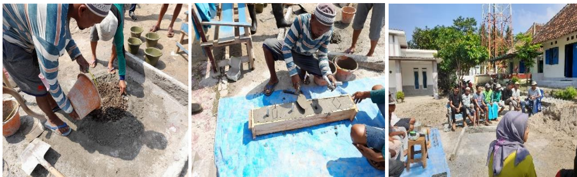
Gambar 3. Pembuatan media karang menggunakan beton
